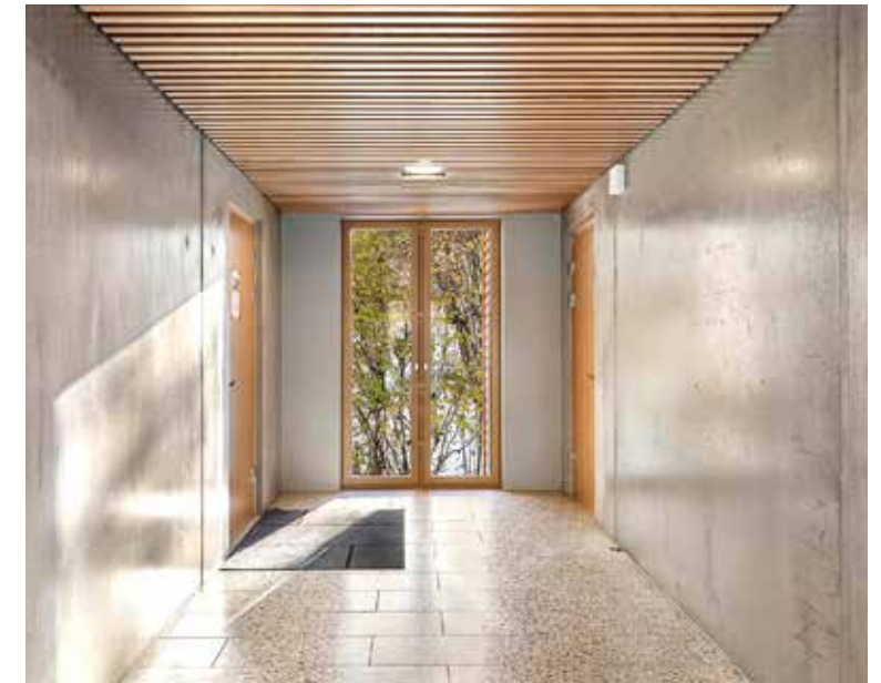
Det er lagt mye arbeid ned i å lage flotte fasader og inngangspartier. Oppgangene består av råbetongvegger, tredører, terrazzofliser på gulv og spiler med flott belysning i tak.
